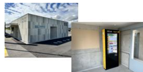
⑩LRT清原工業団地TC付帯施設(待合室) 清原地区市民センター前
