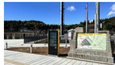
④大谷観光周遊拠点施設 大谷コネクト 大谷コネクトの駐車場入口付近
